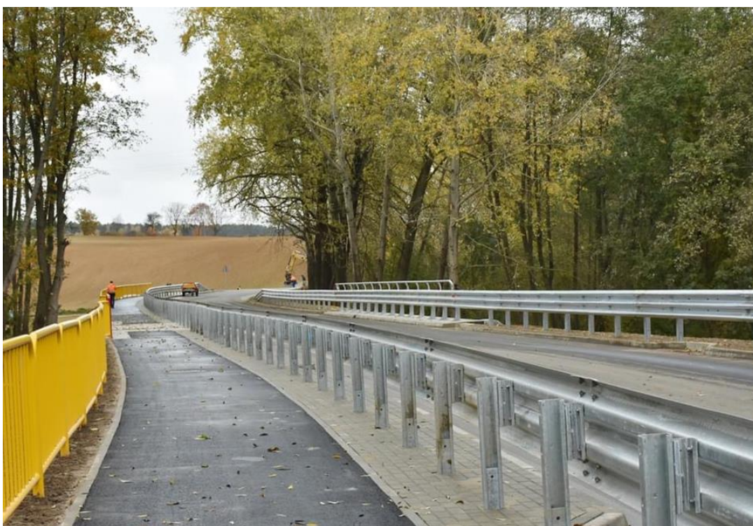
Fot. nr 2 Most w Wójcinie po przebudowie
