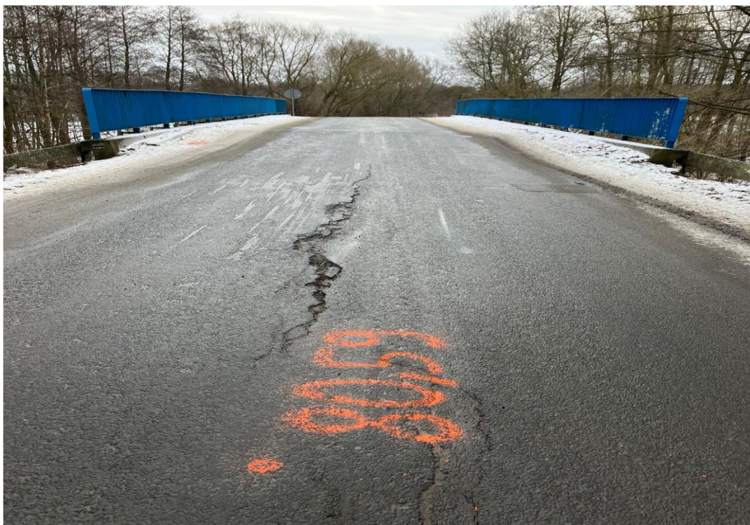
Fot. nr 1 Most w Wójcinie przed przebudową
