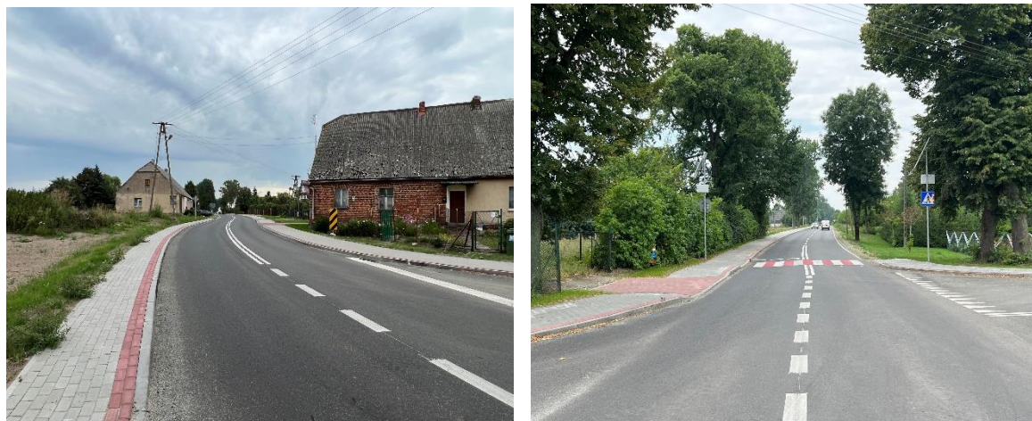
Droga 2314C Żnin – Janowiec Wlkp. Km od 4+500 do km 6+000
