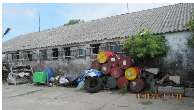
Budynek magazynowy, 1.08.2013 r.
