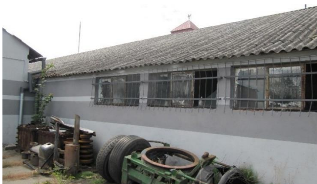
Budynek magazynowy, 26.06.2018 r.
