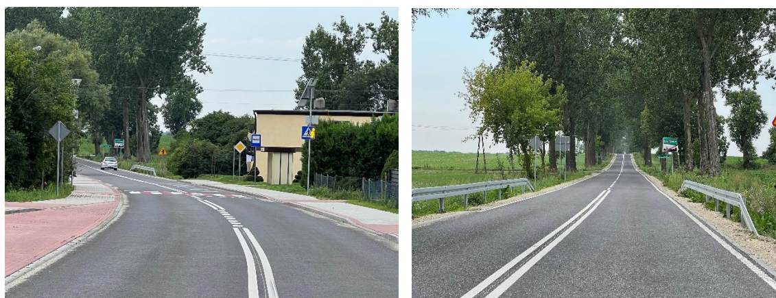
Droga 2314C Żnin – Janowiec Wlkp. Km od 8+300 do km 10+575
