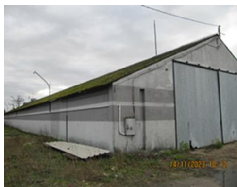
Budynek magazynowy, 14.11.2023 r.
