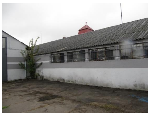
Budynek magazynowy, 10.10.2019 r.
