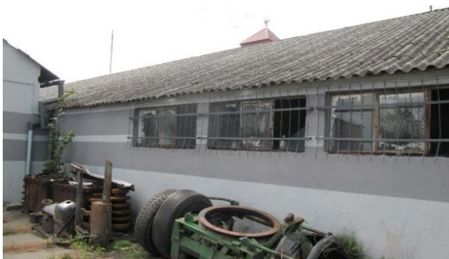
Budynek magazynowy, 26.06.2018 r.
