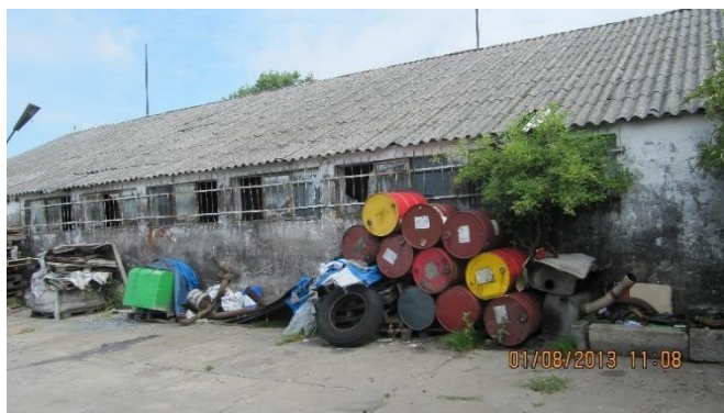
Budynek magazynowy, 1.08.2013 r.
