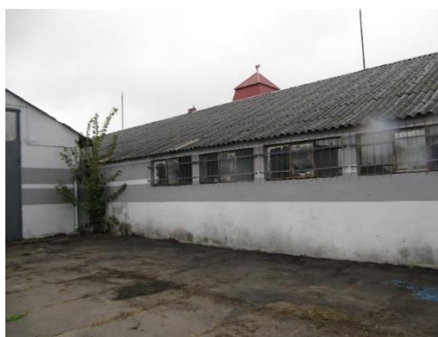
Budynek magazynowy, 10.10.2019 r.
